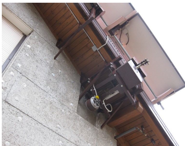
Pogonski mehanizem za vrtenje horizontalne osi, na kateri so sončne celice
