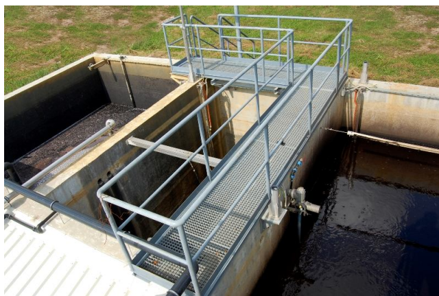
Bazen za čiščenje odpadne vode
